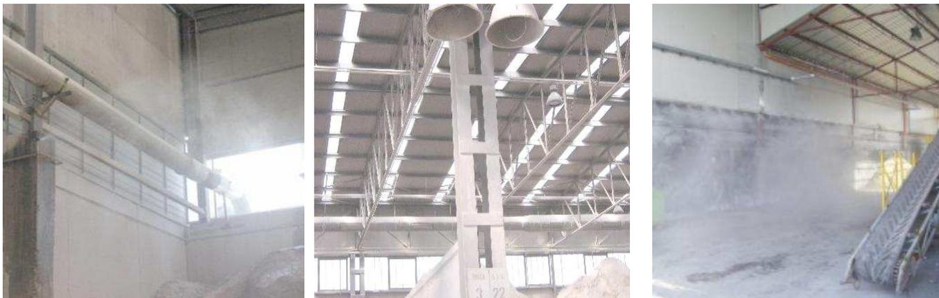
A sx.: contenimento/abbattimento polveri aerodisperse con veli di acqua micronizzata; *al centro*: impianto per il ricambio d'aria (Ceramica).
