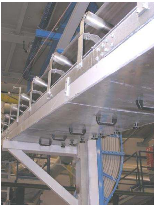
A dx: Nastro e sottostante protezione anticaduta polveri
