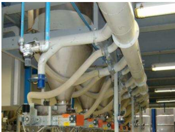
Tubazione con calate per l'aspirazione e raccolta delle polveri aerodisperse all'uscita dei sili.
