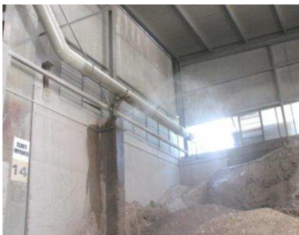
Prevenzione/contenimento delle polveri con pareti, porte protette, velo d'acqua nebulizzata, aspirazione
