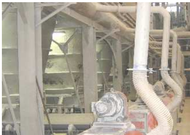
Tubazione con calate per l'aspirazione e raccolta delle polveri aerodisperse all'uscita dei sili.
