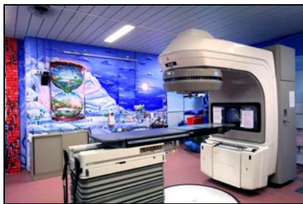
Sala bunker con l'Acceleratore Lineare
